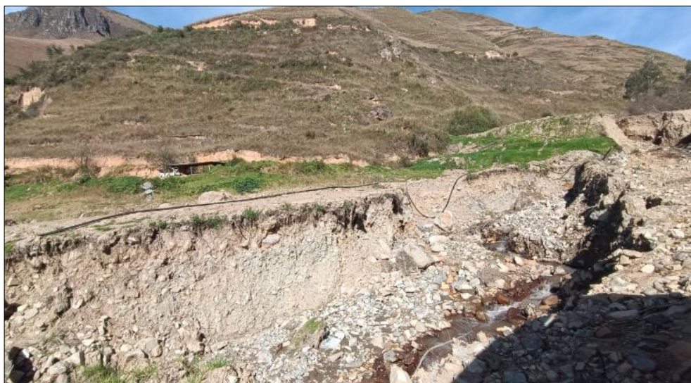
FOTOGRAFIA N°3: Cauce de quebrada con socavación severa en una de sus riberas, mostrando
